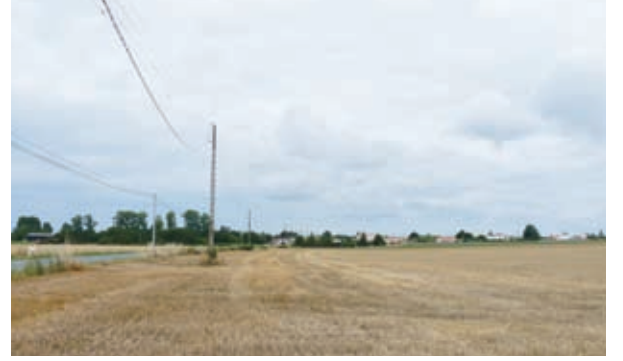
PROMISCUITÉ DES LIGNES ÉLECTRIQUES
