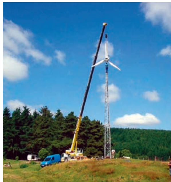
LORS DU MONTAGE DE L'AÉROGÉNÉRATEUR 10KW AIRCON.
