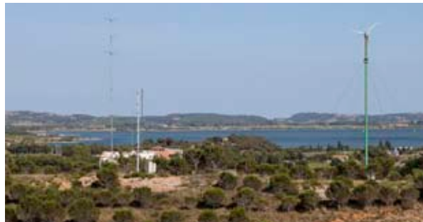
LE SITE D’ESSAI INDÉPENDANT DE NARBONNE TESTE LES MACHINES DURANT 6 MOIS.
