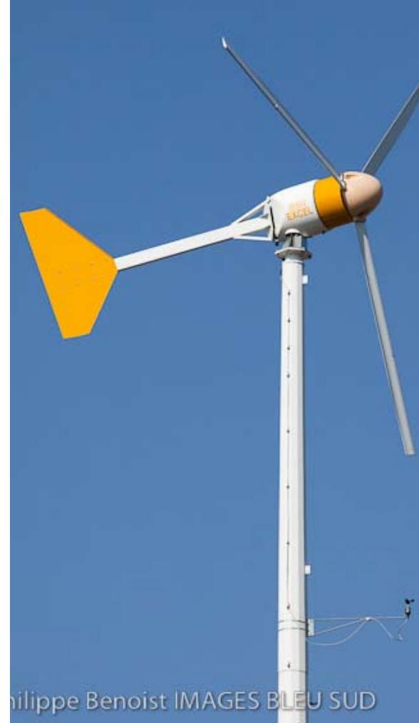
MÂT TUBULAIRE AUTOPORTANT
