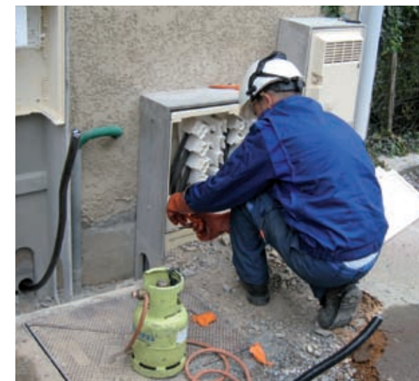
LE RACCORDEMENT DE L'ÉOLIENNE PEUT ÊTRE RÉALISÉ SUR LE TERRAIN OU EN LIMITE DE PROPRIÉTÉ, AVEC UN MAXIMUM DE 30 M.
