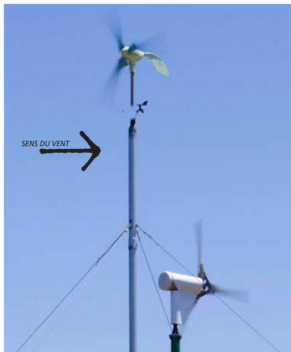
ÉOLIENNE “FACE AU VENT” (GAUCHE) À CÔTÉ D'UNE “SOUS LE VENT” (DROITE).
